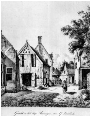
Overstraat (1790-1850) met tabaksschuur met staande luiken.
